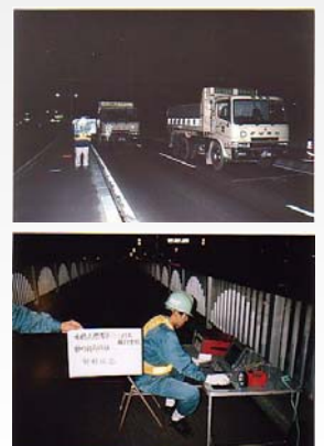
構造物健全度診断 (橋梁応力頻度測定)
