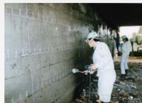
鋼材腐食診断 (自然電位法)
