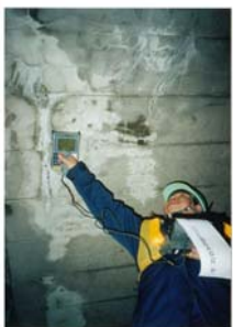
鉄筋探査~RCレーダー (電磁波法)
