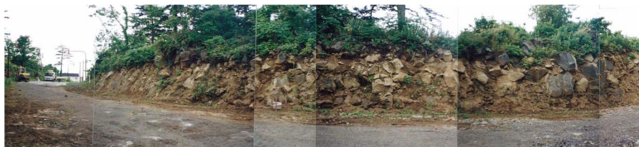
写真-1 暫定切土の法面形状
