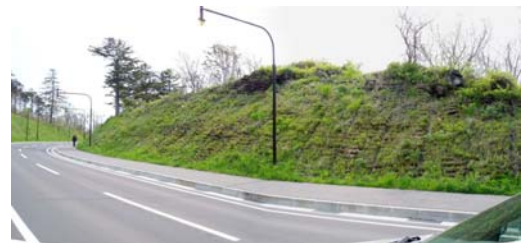
施工後3年で飛来種子が繁茂
