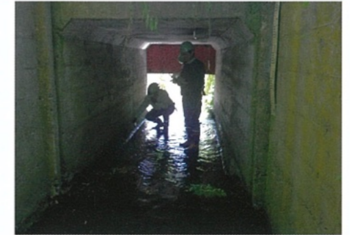
樋門函内の調査状況
