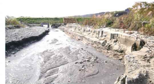
河道内の土砂堆積
