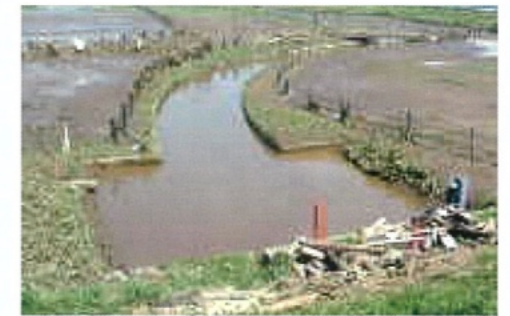
内水被害の状況
