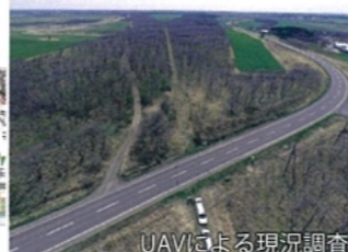
UAVによる現況調査
