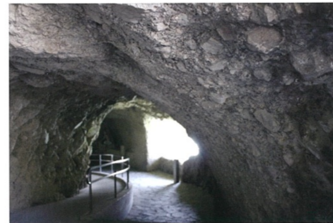
写真4 青の洞門、奥の窓は明り取り用の窓 3)
