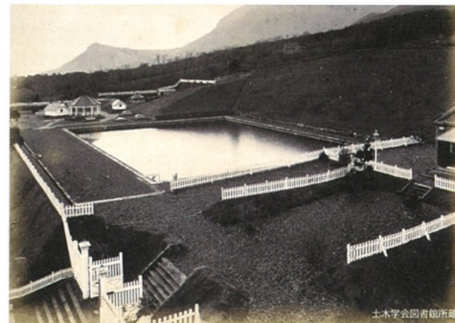
明治22(1889)年完成の函館水道
