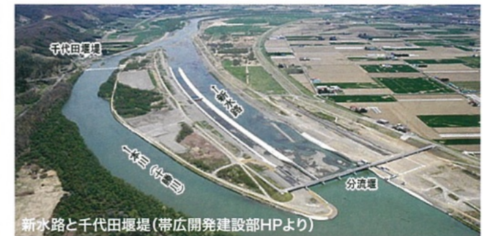
新水路に設置された分流堰 洪水時に開いて流下能力を確保する
