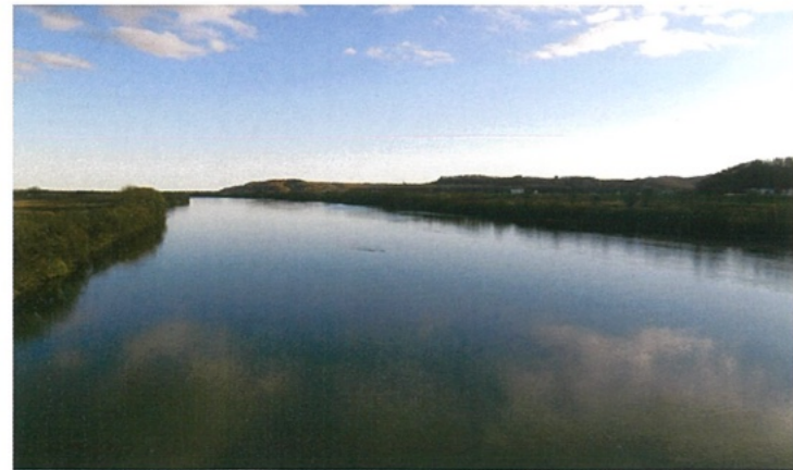
統内新水路(現十勝川) 茂岩橋より下流を望む
