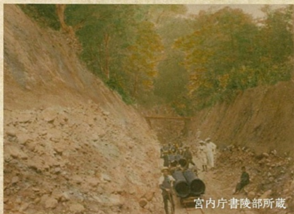
横浜水道建設の様子（横浜水道写真帖）
