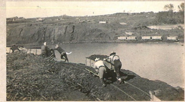
人力による土砂運搬(札幌開発建設部所蔵)
