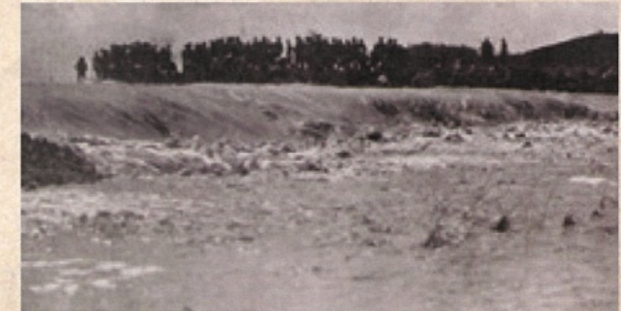
新水路の通水(南幌町史)
