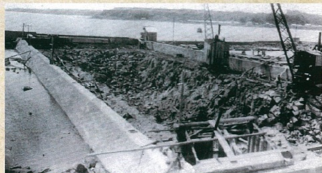
ケーソンドックの建設状況 (網走開発建設部築港課 提供)
