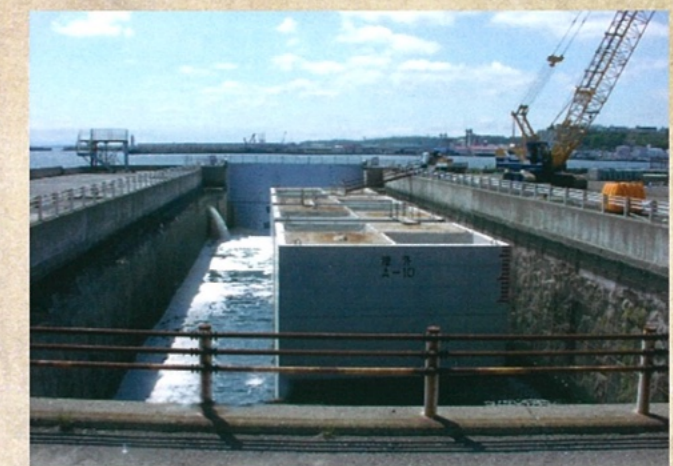
注水中のケーソンドック
