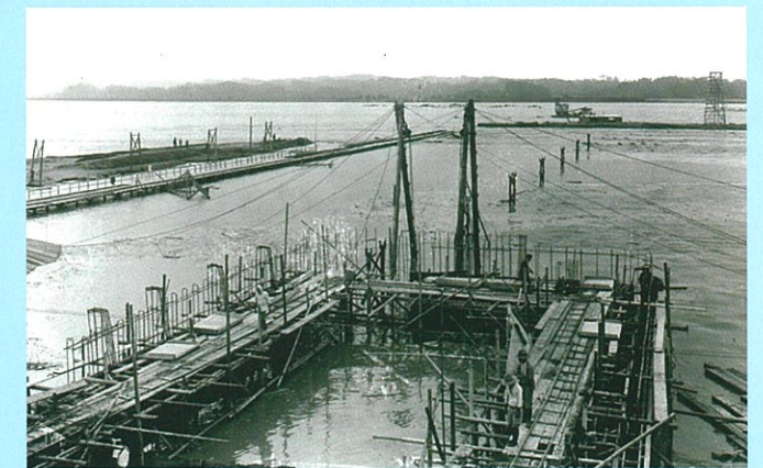
仮締切撤去後の浸水(信濃川大河津資料館 所蔵)
