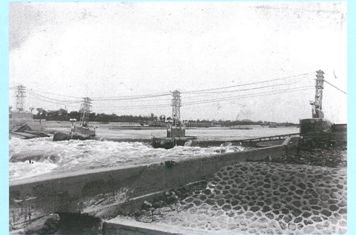
自在堰の陥没(信濃川大河津資料館 所蔵)
