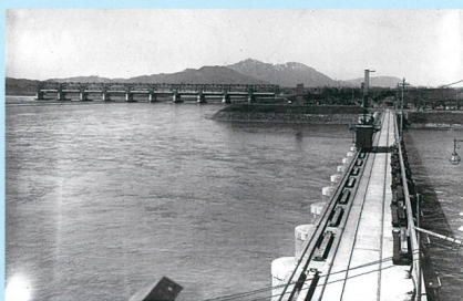
可動堰(左)と洗堰(右) (信濃川大河津資料館 所蔵)
