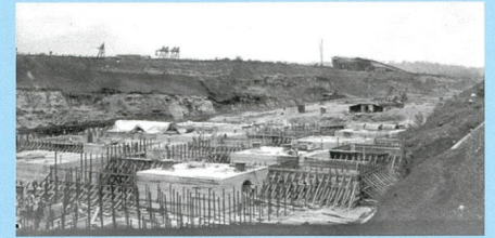
パナマ運河建設の様子：土木学会附属土木図書館提供
