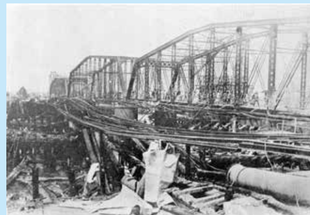
永代橋の火害状況(土木学会附属土木図書館提供)
