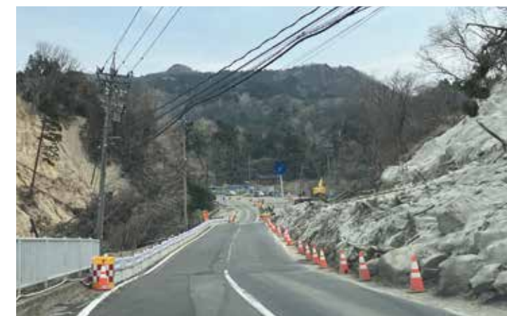
崩積土と一緒に吹付けした応急対策状況
