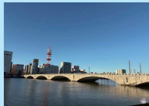
萬代橋(信濃川：昭和4年完成)
