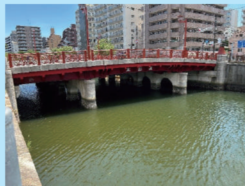
残存する復興局型橋梁 太田橋：横浜大岡川
