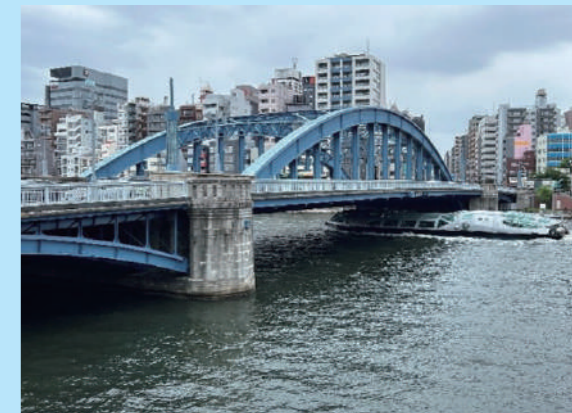
駒形橋(昭和2年完成)
