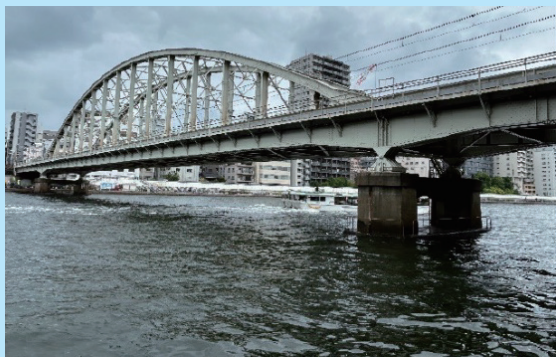
総武本線隅田川橋梁(昭和7年完成)
