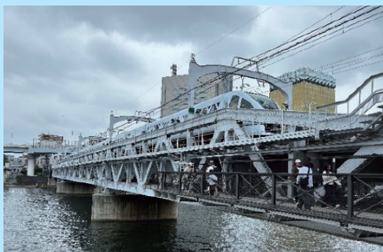
東武伊勢崎線隅田川橋梁(昭和6年完成)
