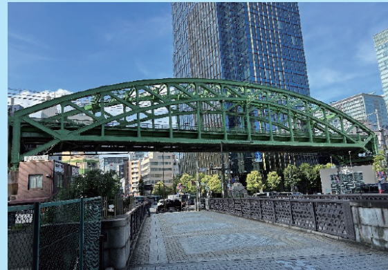
松住町架道橋(昭和7年完成)
